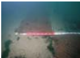
写真 - 7 敷設直後
