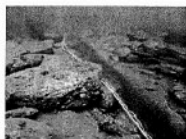
ウニフェンスを作り、設置しました。(H20.5)
