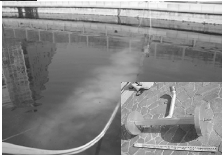
図-5 水底耕耘の様子(右下：微細気泡噴出部)
