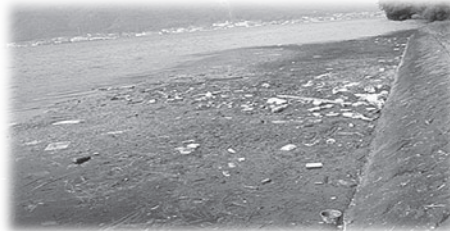
漂流ゴミが多く、アオサ等の腐敗臭がする
